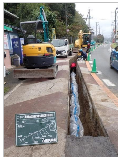
管路の布設替え
