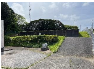
いでのお 出野尾配水場 (受水)
