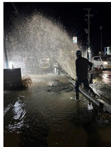
漏水事故の状況
