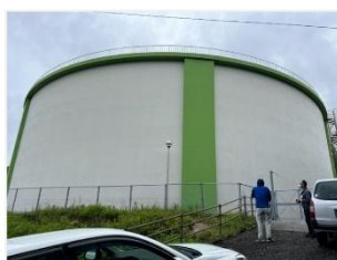
宮本配水場 (受水)
