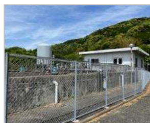
高鶴配水場 (受水)
