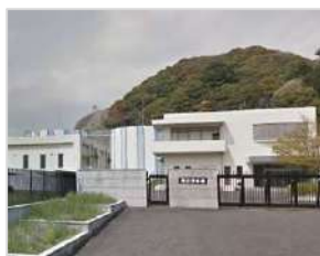
ほだい 保台浄水場
