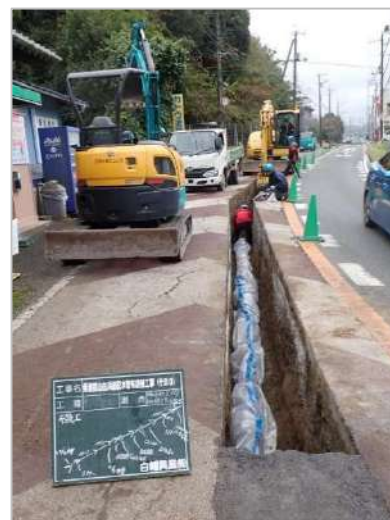
管路の布設替え
